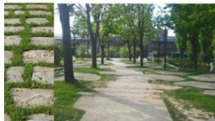
erbés Réemploi des sols en dalles posées en opus
