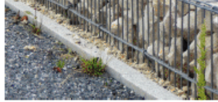
GABIONS CALCAIRE ET CAGE GALVA murets
