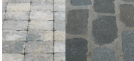
PAVÉ CARRÉ JOINTÉ ET ENHERBÉ sois accès
