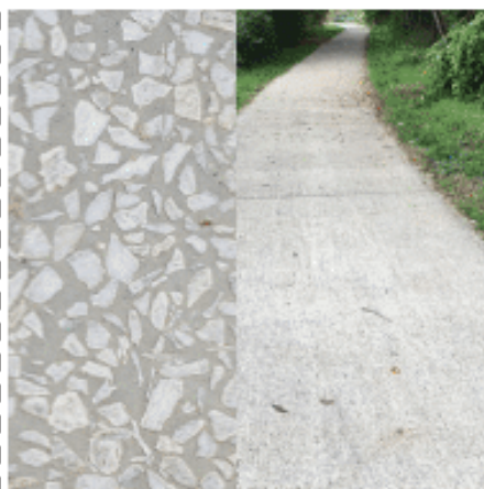
BÉTON DÉACTIVE GRANULAT CALCAIRE BLANC chemin découverte
